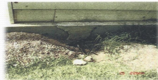
Detalle de la caja.
